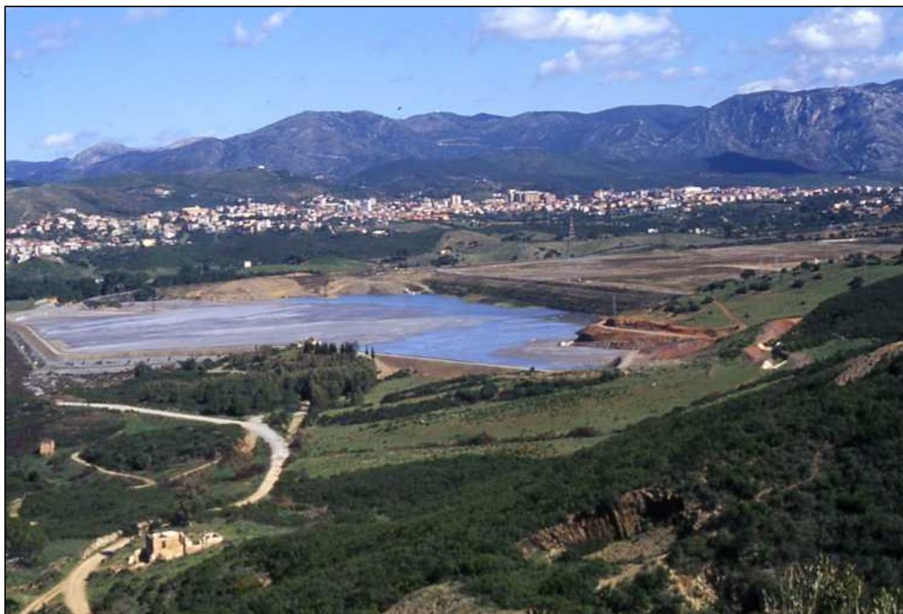
FIGURA 9 IMMAGINE DEI BACINI FANGHI STERILI NEGLI ANNI '90 DEL SECOLO SCORSO, DURANTE IL FUNZIONAMENTO DELL'IMPIANTO MINERALURGICO DI CAMPO PISANO. LA SPIANATA DEL BACINO È RICOPERTA DA UNA LAMA D'ACQUA SUPERFICIALE
