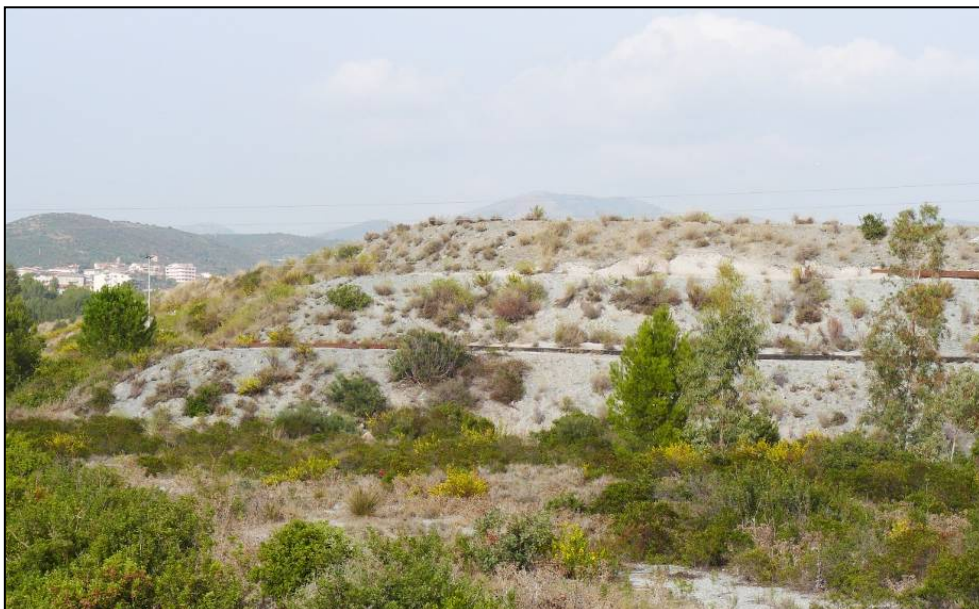
FIGURA 87 PORZIONE DELL’ARGINE DEL BACINO FANGHI STERILI DI SAN GIORGIO REALIZZATO CON GLI ARGILLOSCISTI SCAVATI SUL POSTO
